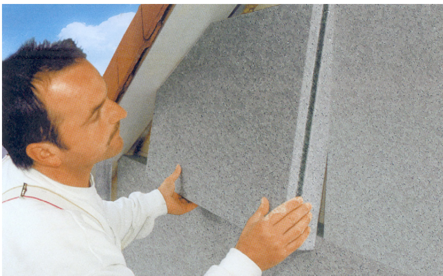
Fassadendämmung lohnt sich, betont die Verbraucherzentrale Energieberatung
